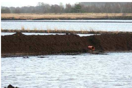
Abb. 31: Kammerung und Überläufe auf Fläche 2 in TG 2
