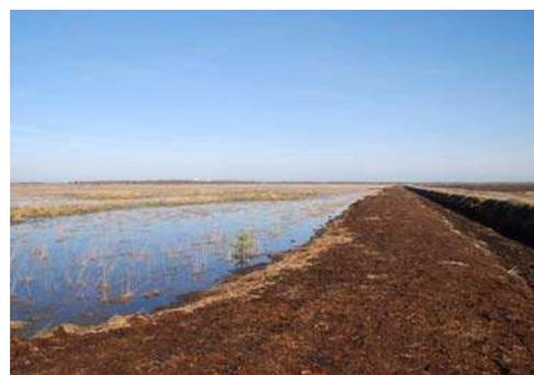
Abb. 35: Einseitige Abschrägung eines Hauptgrabens und Verwallung auf Flächenkomplex B in TG 1, Herbst 2010
