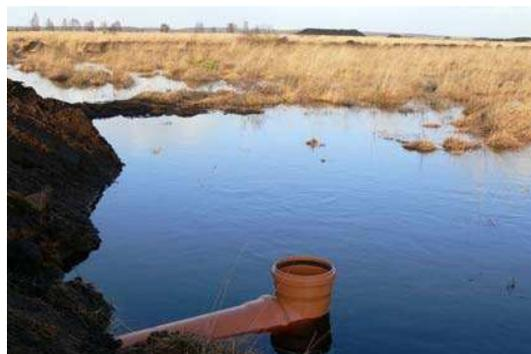
Abb. 28: Einbau von regulierbaren Überläufen in TG 2
